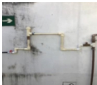
Figura 6: Estação de Cupom na A.C. Circulante
