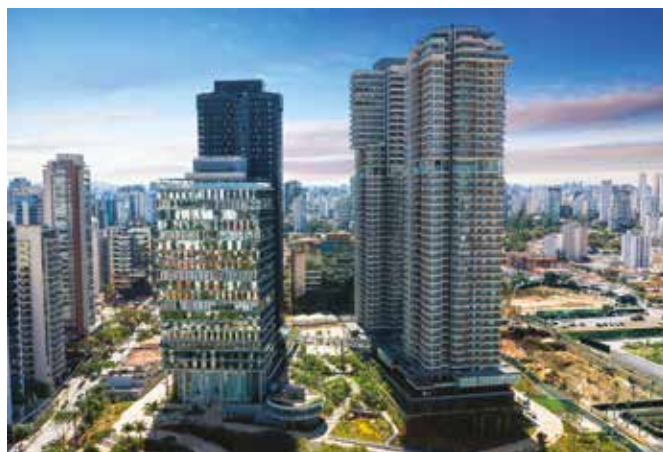
Obra: Conjunto Comercial O Parque - São Paulo SP Instalador: Best Clima Engenharia e Instalações
