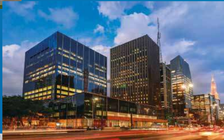
Retrofit Brazilian Financial Center (BFC) São Paulo/SP Instalador: Star Center Forneceu: Chillers
