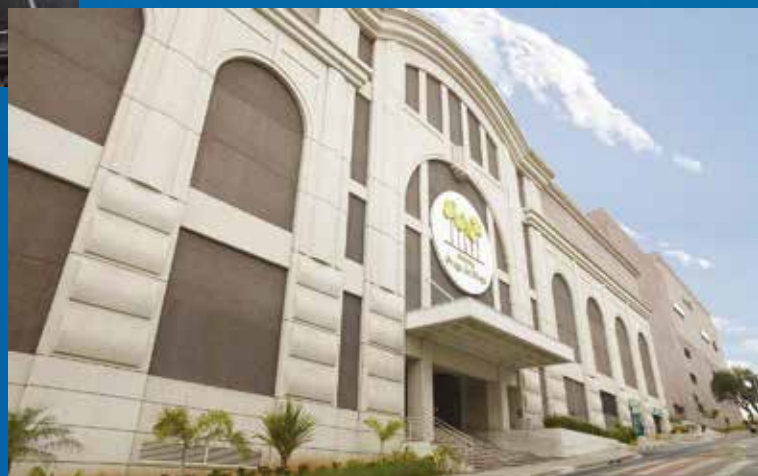
Retrofit HVAC, Aut.e IoT do Shop. Praça da Moça – Diadema/SP Instalador: SET Sociedade de Engenharia Térmica Forneceu: Chillers
