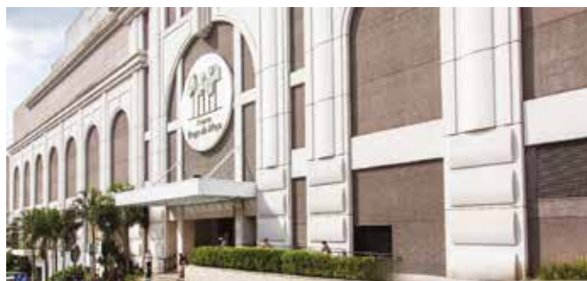
Obra: Shopping Praça da Moça - Diadema SP Instalador: SET Sociedade de Engenharia Térmica
