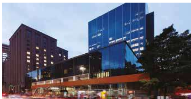
Obra: BFC Corporate Building Retrofit - São Paulo SP Instalador: Star Center Soluções em Climatização
