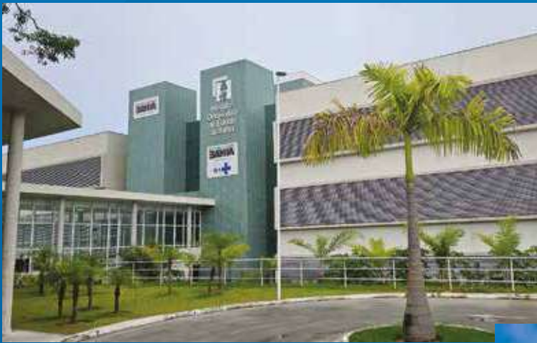
Hospital Ortopédico da Bahia – Salvador/BA Instalador: Artemp Engenharia Térmica Forneceu: Chillers, condicionadores e Splitões
