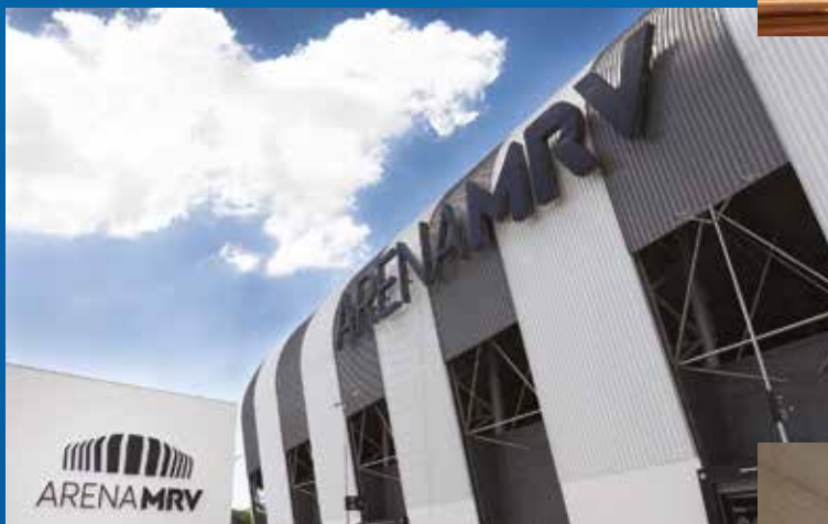
Arena MRV (Arena do Galo) – Belo Horizonte/MG Instalador: JAM Engenharia Forneceu: VRF, Controles, Splitões e Automação Conforto e qualidade do ambiente
