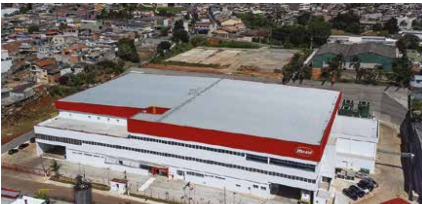
Obra: Fábrica de Chocolates Harald - Santana do Parnaíba SP Instalador: Newset Tecnologia em Climatização
