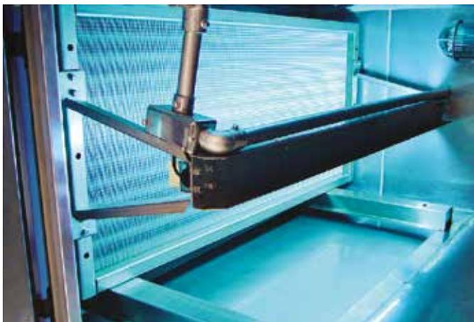
Emissores de UVC em ação na serpentina evitam a formação do biofilme
