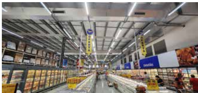
Interior da loja com destaque para os dutos octogonais
