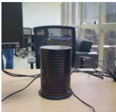
Ventilação personalizada na Assembleia Legislativa de Pernambuco
