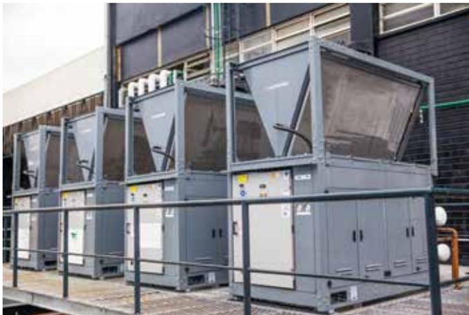
Figura 2: Chillers para sistemas de refrigeração remoto (Eletrofrío Refrigeração)
