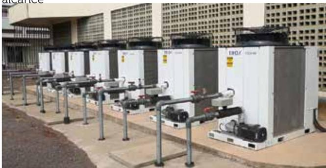
Chillers inverter modulares com condensação a ar
