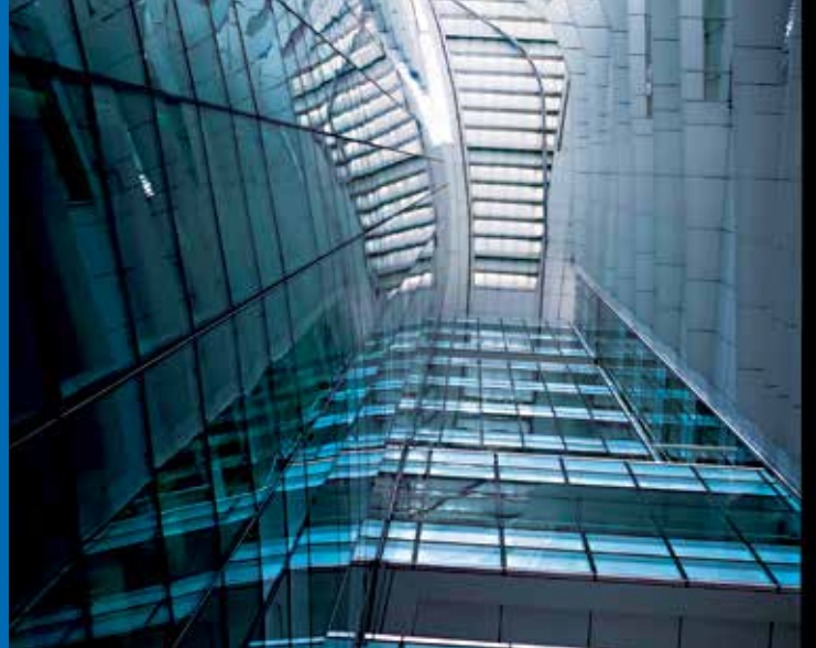
Foto da capa: Detalhe do túnel de vento no Edifício da Biblioteca Nacional em Singapura que mantém a área fresca à medida que o calor é aspirado e dissipado pelas estruturas gigantes em forma de barbatana.
