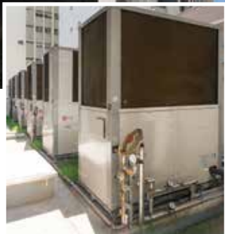
Condensadoras foram distribuídas ao longo dos andares
