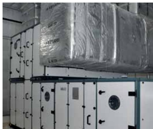
Unidades de tratamento do ar com rodas entálpicas e ventiladores *plenum fan* e motores EC
