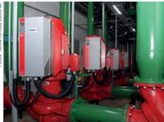
Bombas *in line* operam com sistema *sensorless*
